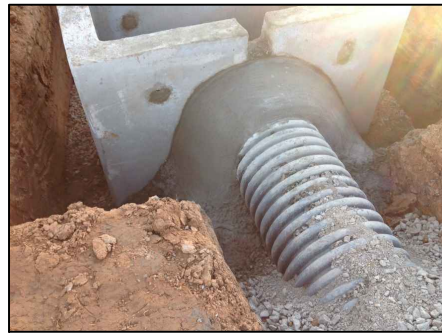
A GROUTED CONNECTION: STRUCTURE OPENING (D) ≤ PIPE OD+6"
